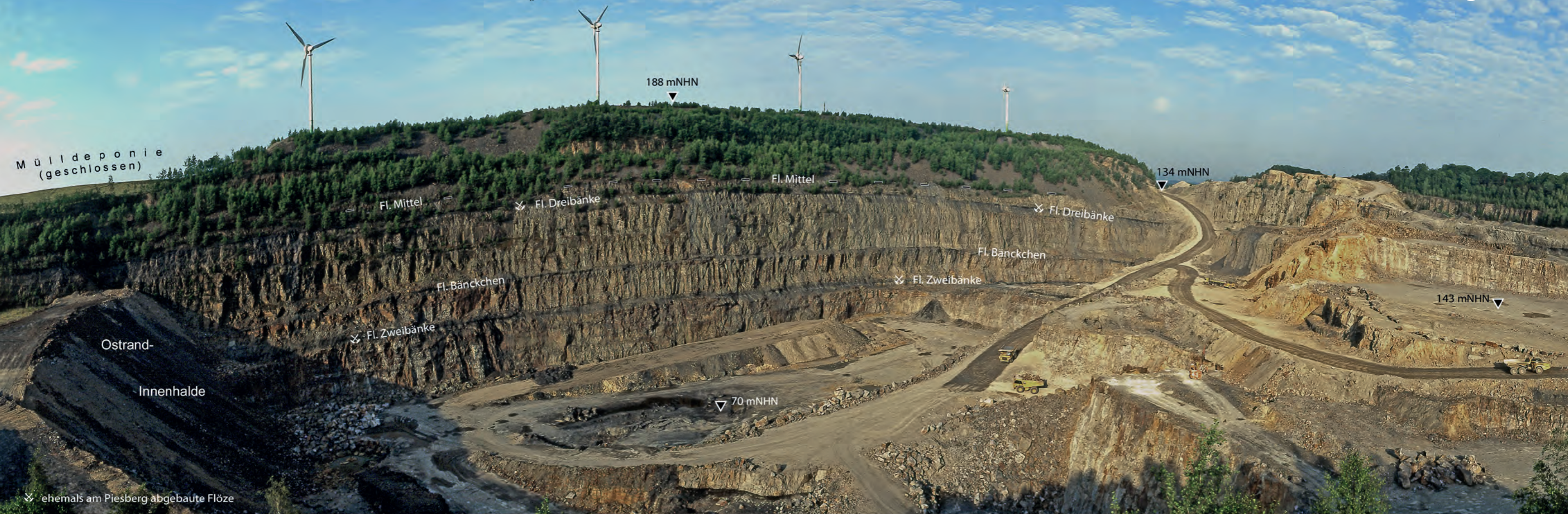
Südwall des Piesberg-Steinbruchs, aufgenommen im Sommer 2000 von der Oberkante der Steinbruch-Ostwand aus. Bildquelle: Stadt Osnabrück, Projektbüro Piesberg. Höhenangaben: nach Planunterlagen der Fa. CEMEX Kies & Sand GmbH. Flöze: Franz-Jürgen Harms & Angelika Leipner.
