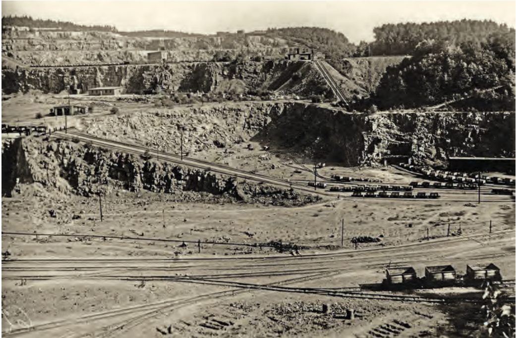
Abb. 2: Blick über die Brechersohle (90-Meter-Sohle im Bildvordergrund) nach Nordosten über das Steinbruchgelände am Westabhang des Piesbergs, aufgenommen vermutlich in den 1930er Jahren. Bis in die 1950er Jahre hinein erfolgte der Transport des gebrochenen Gesteins in schienengebundenen Förderwagen, die zunächst von Pferden, ab 1909/10 hauptsächlich mit Kleinlokomotiven bewegt wurden. Zur Überwindung von Höhenunterschieden gab es Bremsberge, auf denen die Förderwagen mit Hilfe von Kettenbahnen gezogen wurden. Zwei dieser Bremsberge sind auf dem Bild zu erkennen: die Brechersohle ist durch einen Bremsberg (linke Bildhälfte) mit der 1. Sohle (ca. 104 m üB. NN) verbunden, ein zweiter Bremsberg (rechte Bildhälfte) verläuft – teilweise in einem Tunnel – bis zur 2. Sohle (ca. 118 m üB. NN). – Bildquelle: Nachlass Walter Öhm im Museum am Schölerberg (Osnabrück).
